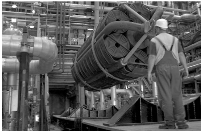
A kiemelt csőköteg-spirál vagonra emelése
