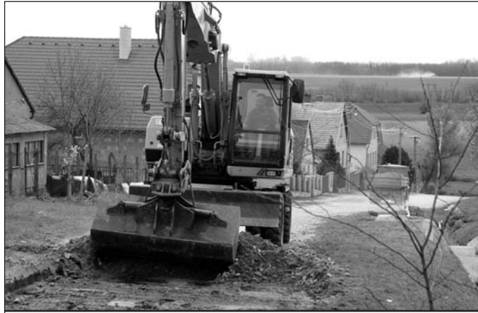
Szilárd útburkolatot kap a Toldi utca alsó szakasza.
