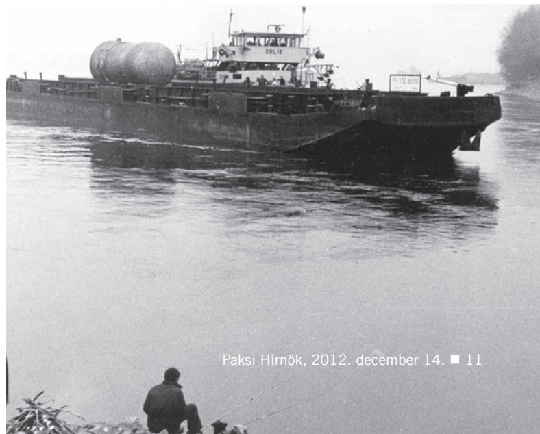
Az Orlik fedélzetén megérkezett a nehéz kikötőbe a 215 tonna súlyú 1. számú reaktortartály (1980. május 24.)
