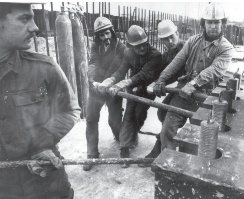
Százhalombattáról érkezett az atomerőmű gépházának vasszerkezetét szerelő, Talpas Illés vezette brigád (1981 márciusa)
